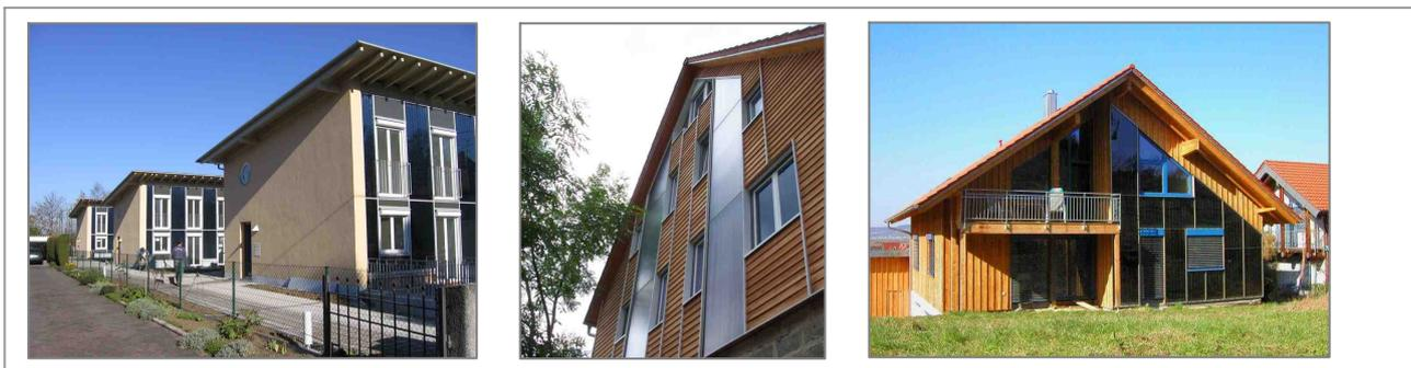
Funktionsgebäude bieten in der Regel günstigere Voraussetzungen, größere zusammenhängende Solarflächen in der Fassade unterzubringen. Eine leichte Schrägstellung der Kollektoren um 10° bis 20° verbessert den Solarertrag um ca. 5%; größere Winkelabweichungen aus der Senkrechten können den optischen Gesamteindruck beeinträchtigen.
